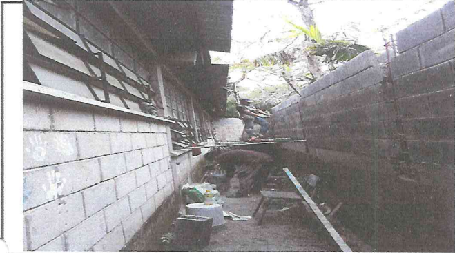
Foto 1: Cisculación de muro con block por maya
