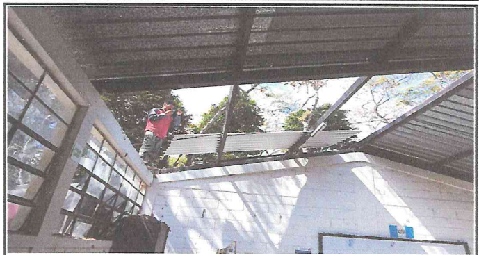
Foto 2: Trabajo de cambio de techo
