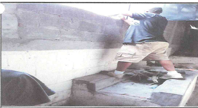
Foto 5: Arreglo de Cosina y colocación de ventanas
